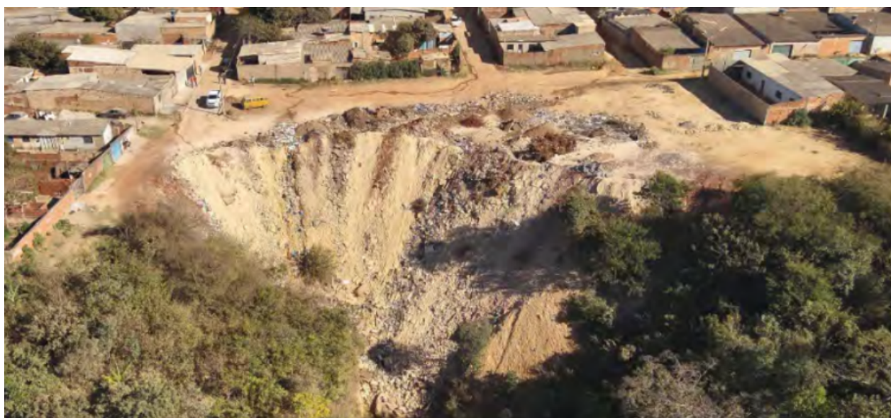
Figura 2. Exemplo de erosão presente no Trecho III do Sol Nascente. Fonte: Laboratório Periférico.
