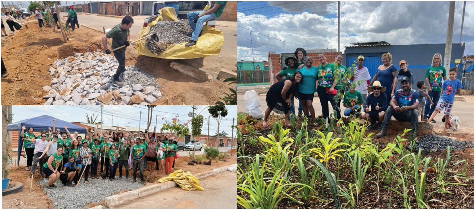
Figura 155: Registros dos encontros práticos para construção do jardim de chuva
